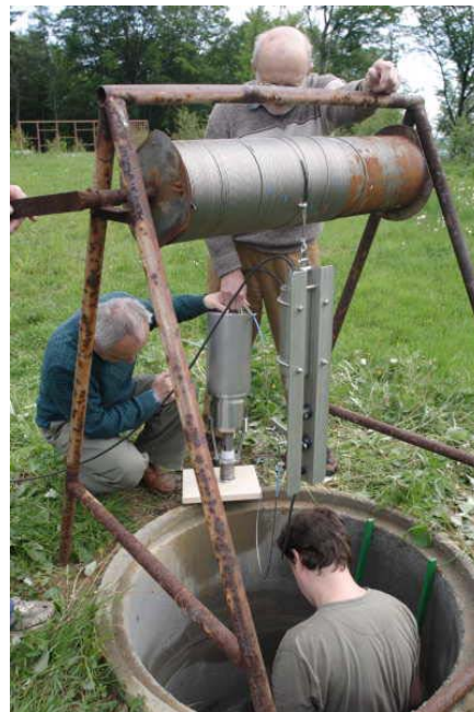
Obr. 9 - Instalace seismometru fy Guralp do vrtu hlubokého 60 m
